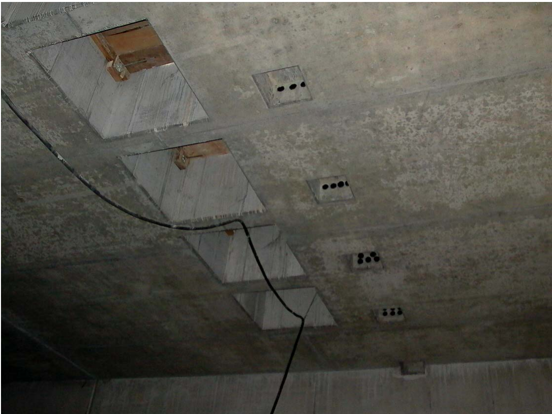
Unterseite der Schächte und Nischen für die Entrauchungsventilatoren und Kabel (20. Mai 2004).
