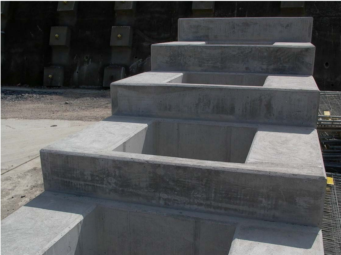
Oberseite der Schächte für die Entrauchungsventilatoren (20. Mai 2004).
